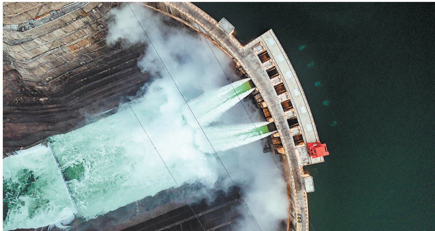
白鹤滩水电站一景(12月19日摄,无人机照片)。
