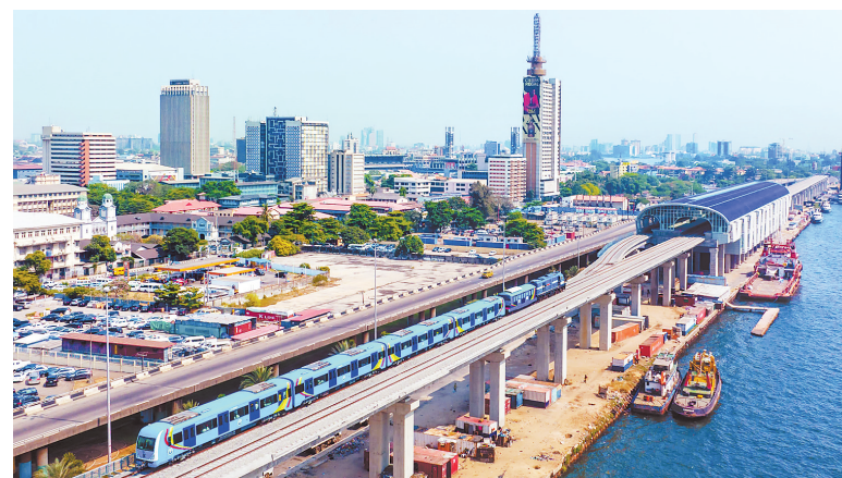
这是12月21日在尼日利亚拉各斯拍摄的一列轻轨列车。由中国土木工程集团有限公司承建的尼日利亚西南部拉各斯轻轨蓝线项目一期工程21日举行竣工仪式，这是该州首条竣工并即将投入运营的轻轨线路。
