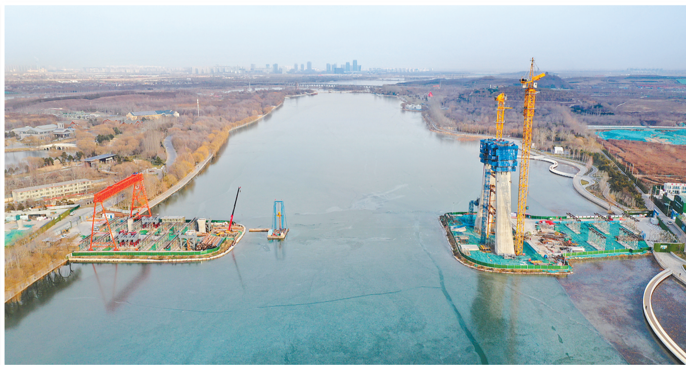
▲12月21日,石家庄太平河片区学府路东延跨太平河大桥施工现场。
