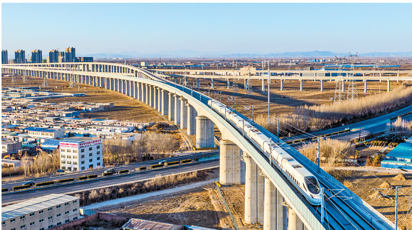
12月27日,动车组列车驶过京唐城际铁路唐山特大桥。
