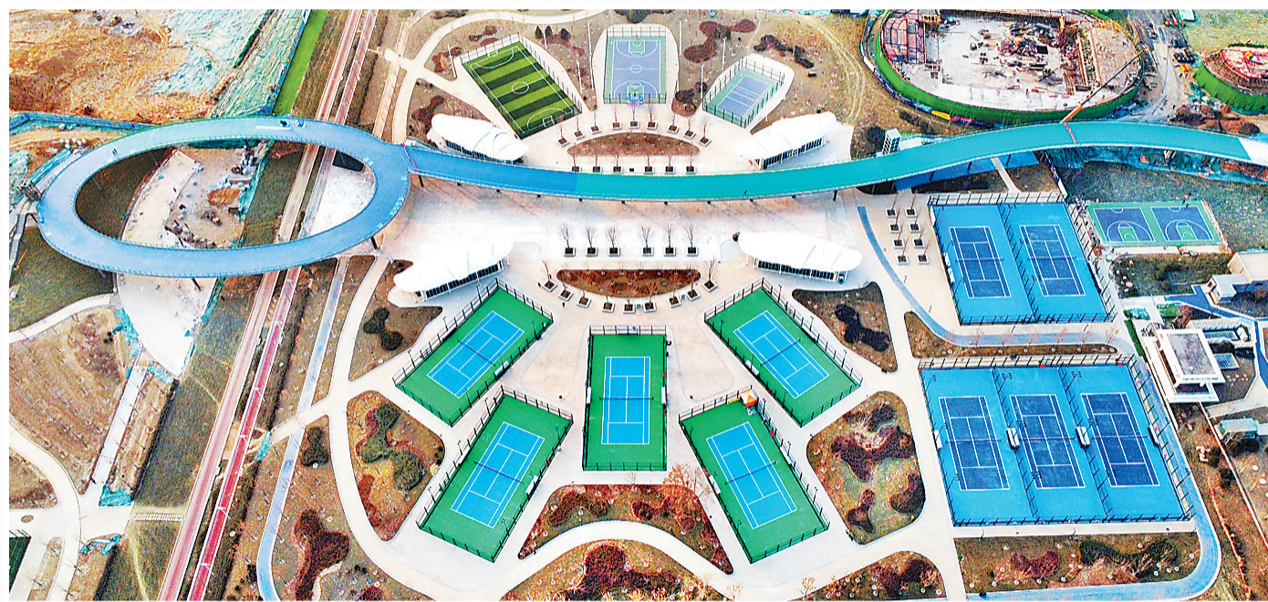
1月1日正式开放的石家庄高铁片区中央绿色体育公园。 河北日报通讯员 张晓峰摄
