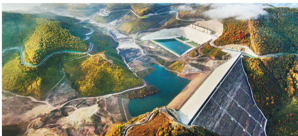
国开行河北省分行信贷支持的丰宁抽水蓄能项目。
