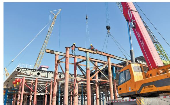
1月31日,在廊坊临空经济区临空大道二期项目现场,中交一公局集团建设者进行永定河特大桥(以下简称临空大桥)钢箱梁吊装施工。临空大桥位于临空大道广兴道至廊涿路段,整体桥长2047米,桥宽47米,双向八车道,桥梁跨越永定河及南北侧防洪堤,预计今年4月底具备通车条件。
