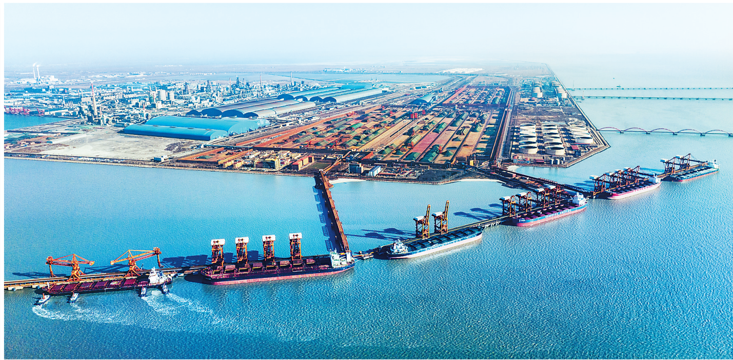
上图:繁忙的唐山港曹妃甸港区矿石码头。
