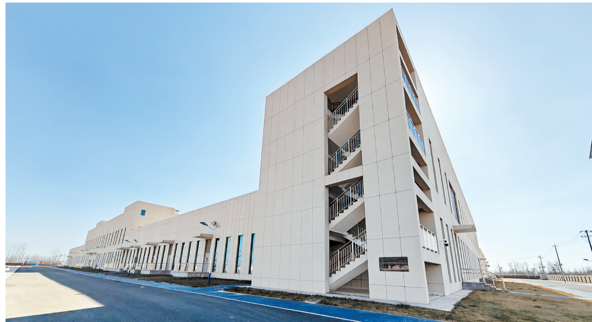
图为位于涿州国家农业科技园区的模式动物项目表型及实验楼。河北日报记者 李连成摄
