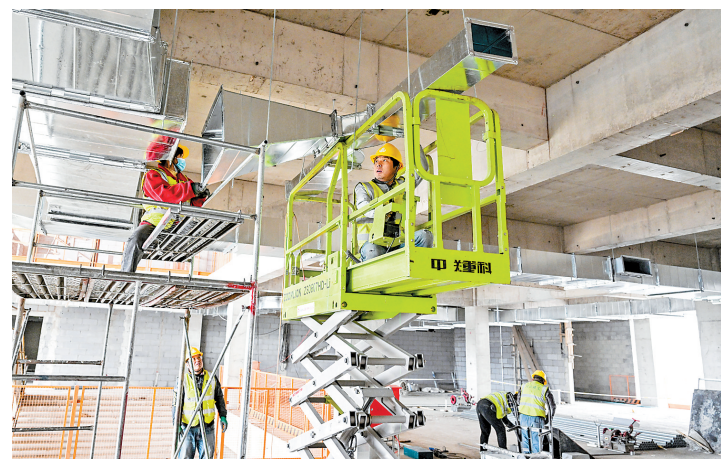
3月16日，河北省第七届(定州)园博会主展馆项目建设有序推进，工人们在认真施工。该项目分为文化中心、体育馆、会展中心、全民健身中心和剧场等5个单体结构，预计今年下半年部分场馆可投入使用。 河北日报记者 耿辉摄
