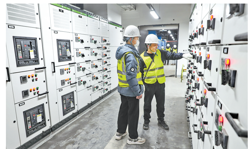
近日,工人在张家口市合盈数据(怀来)科技产业园项目建设现场施工。合盈数据(怀来)科技产业园是环京地区首个绿色零碳数据中心集群,建成后可承载服务器100万台,将为京津冀以及全国互联网、智能网联及高精尖产业发展提供有力支撑。河北日报通讯员 武殿森摄
