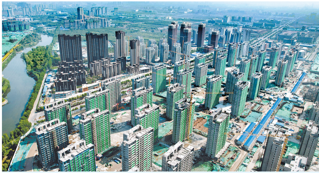
4月25日拍摄的中铁二十局承建的石家庄市高新技术产业开发区集中安置区棚户区改造项目建设工地。近年来，河北省持续推进棚户区改造，有效改善群众住房条件，惠及民生。据了解，截至2022年底，河北省已累计完成棚户区改造安置房建设达260万套，惠及居民达500万人。今年还将开工建设棚户区改造安置房12万套。新华社记者 杨世尧摄
