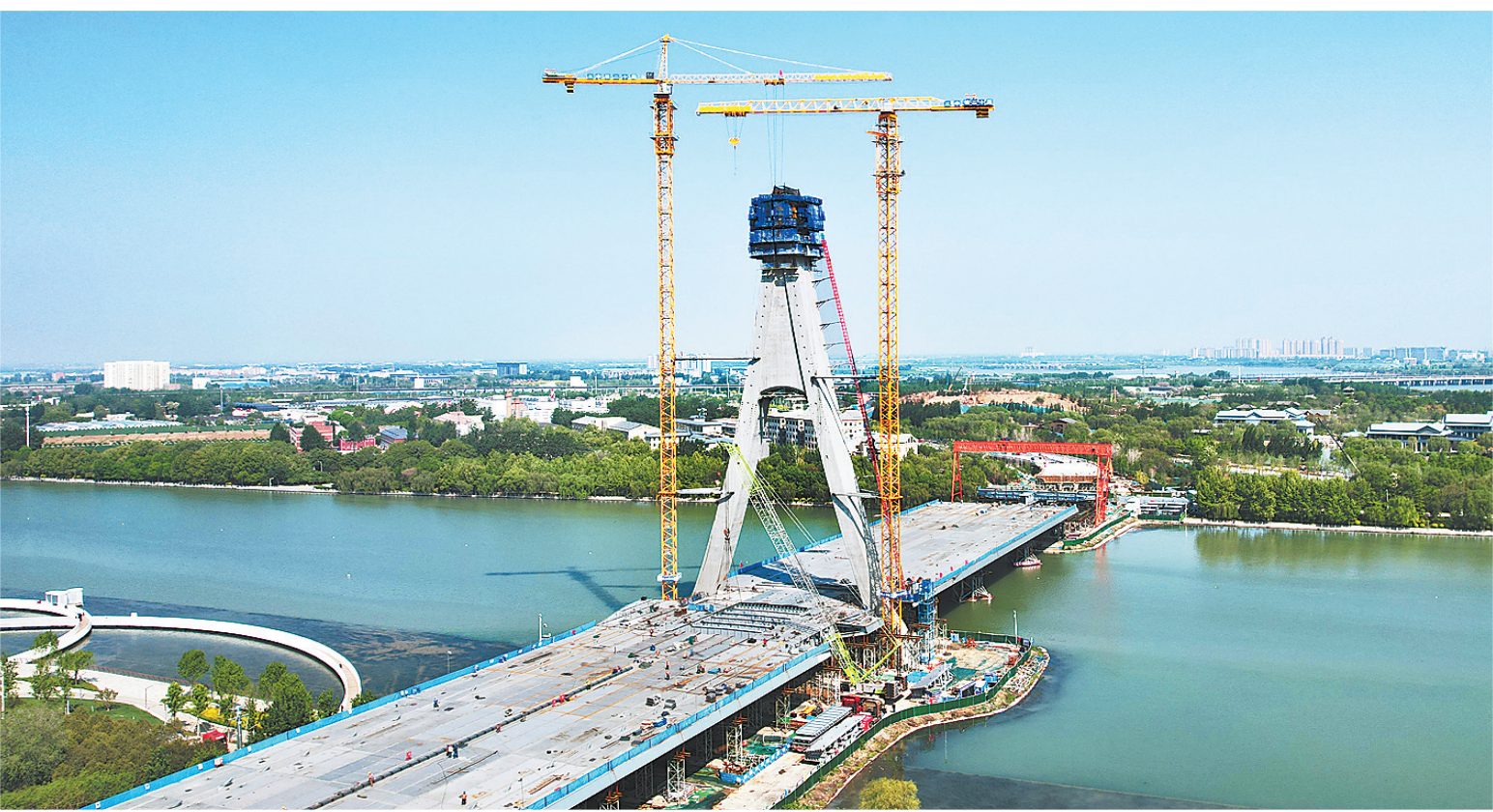
日前,随着第 16 节钢箱梁拼装完成,中铁二十局负责施工的河北省单塔跨径最大斜拉桥——石家庄学府路东延跨太平河桥主桥合龙。学府路东延跨太平河桥总长约 1.39 公里,主桥长 300 米,最大跨径 160 米,主塔高 102.75 米。该桥预计 5 月底建成通车。
