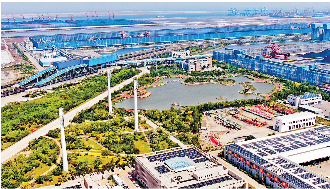
5月12日,航拍下的黄骅港煤炭港区区内景色。如今这里已成为一座鸟语花香的“海岸花园”。 河北日报记者 张 昊摄
