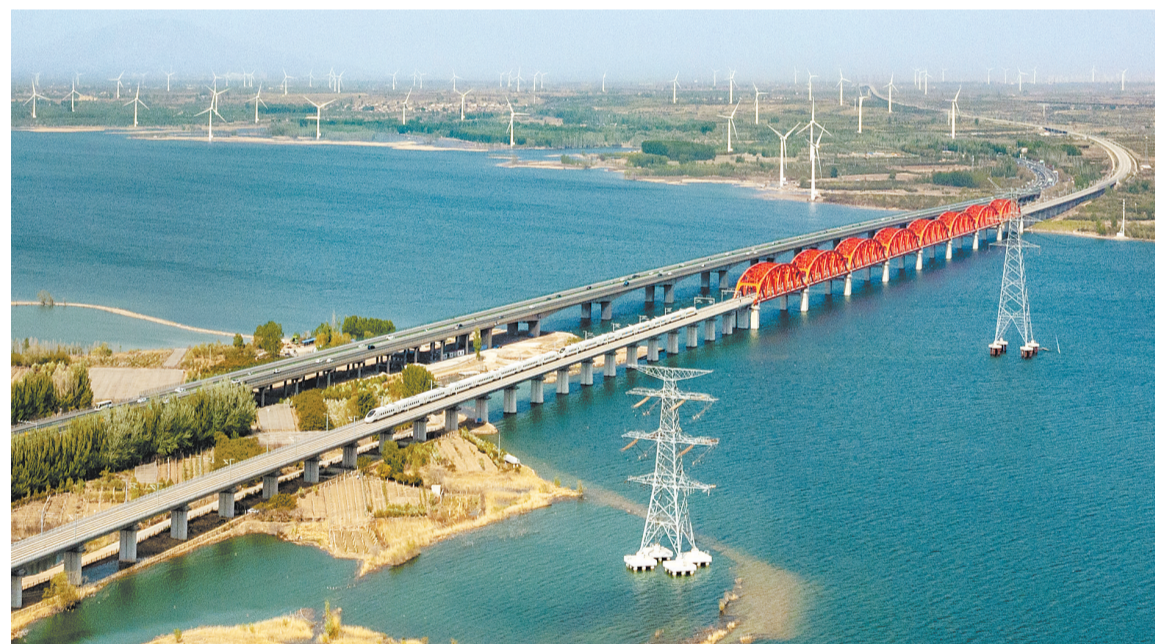
5月3日,一列“复兴号”动车组列车驶过京张高铁官厅水库特大桥。通过体育牵引、文化赋能、旅游带动,京张体育文化旅游带建设加快推进。 河北日报记者 李东宇摄
