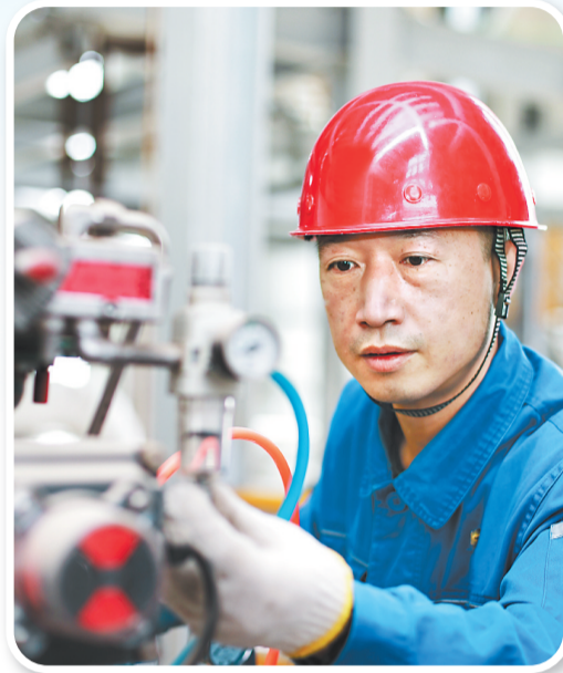
张宣科技技术人员正在检查氢冶金设备运行情况。
