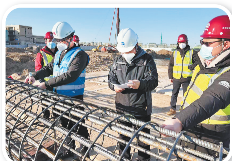
容西安置房项目团队工作人员到工程一线巡查。
