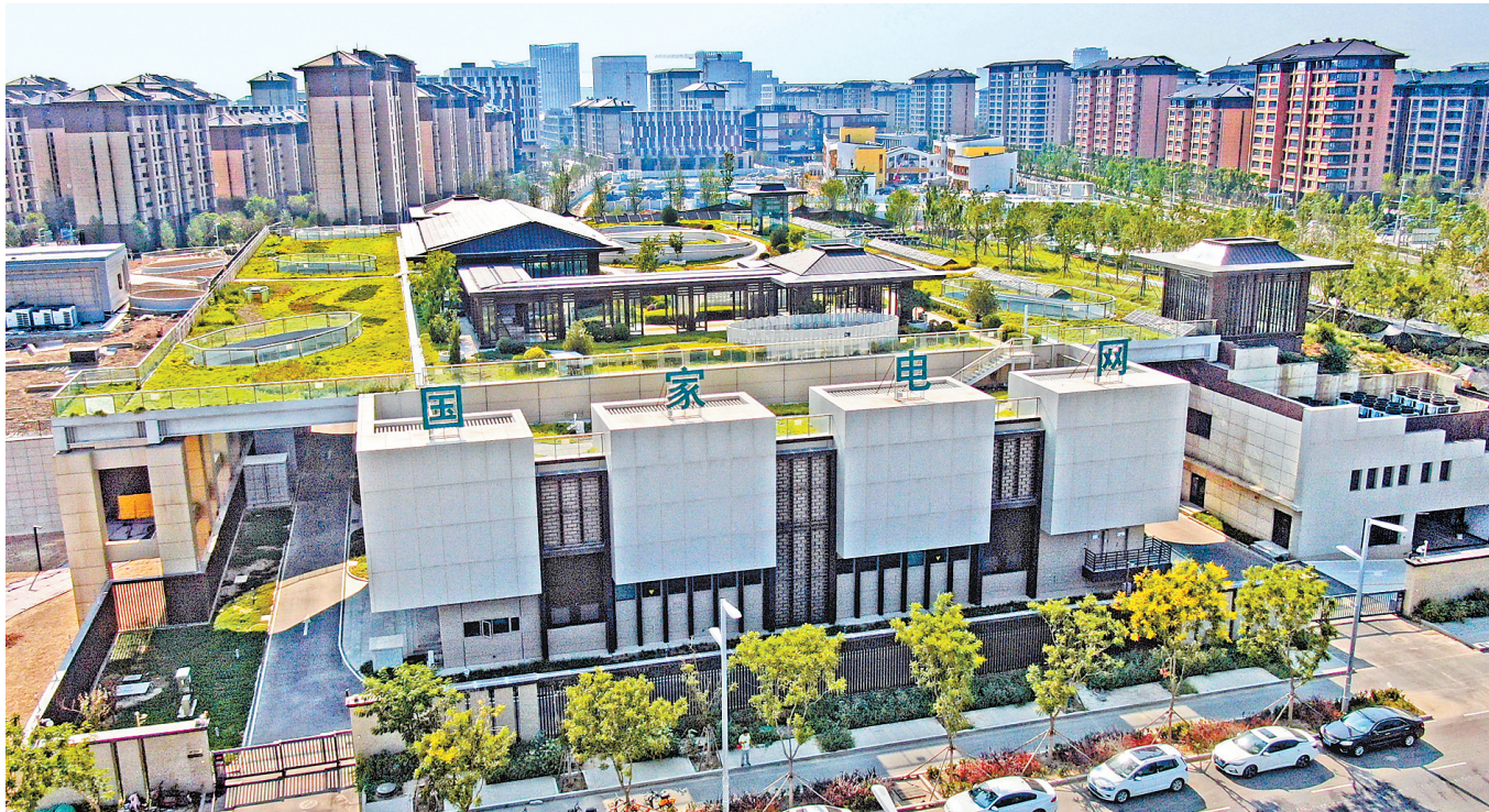
7月19日拍摄的雄安新区剧村城市智慧能源融合站。
