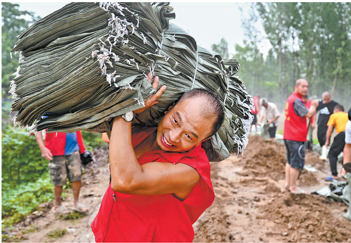
8月1日，涿州市西茨村干部群众主动参加堤坝加固。河北日报记者 张昊摄
