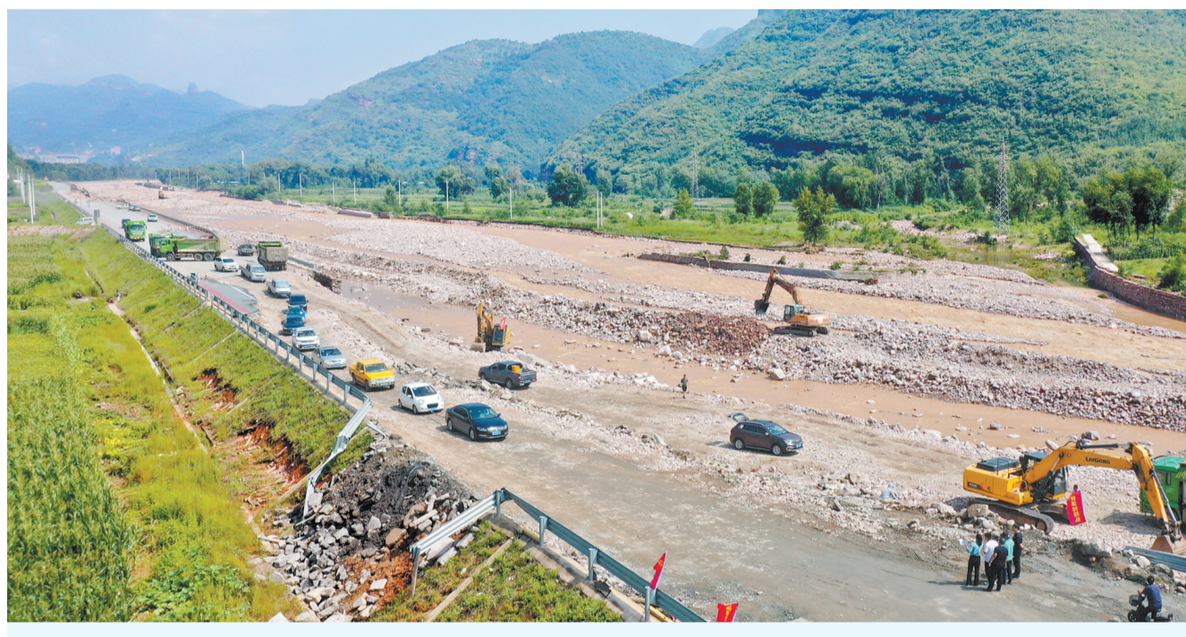
8月2日,武安市交通运输局工作人员对国道G234兴阳公路(武安市平安大道)水毁路段进行抢通后的路基加固作业。经昼夜奋战,目前武安市水毁道路已基本恢复通车。河北日报记者 史晨全摄
