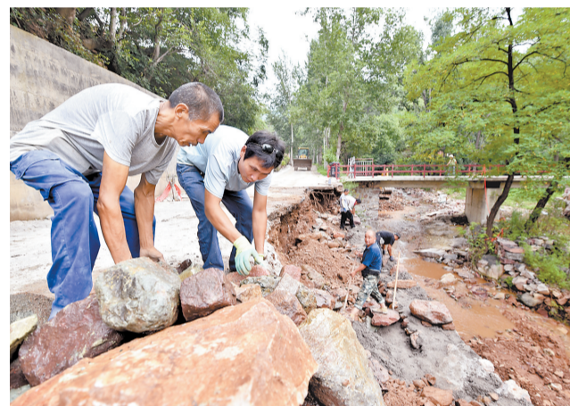
▲8月7日,井陘县苍岩山镇中罗峪村村委会组织群众修复进村道路。河北日报记者 史晟全摄
