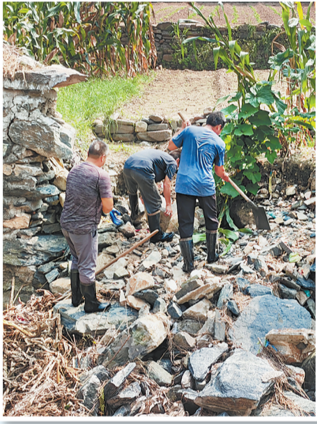
8月16日，内丘县獐乡田白芷村的村民志愿者在修复村里受损的河堤。
