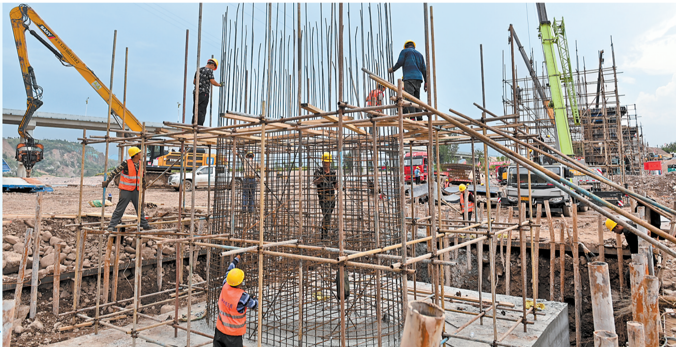
8月29日,施工人员抢修石太铁路货运线并段在洪水中受损的铁路桥,力争早日恢复通车。河北日报记者 史晟全摄
