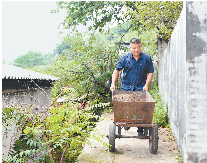
8月6日,临城县赵庄乡梁家庄村党支部书记、村委会主任郝立杰,帮村民重垒被洪水冲垮的院墙。
