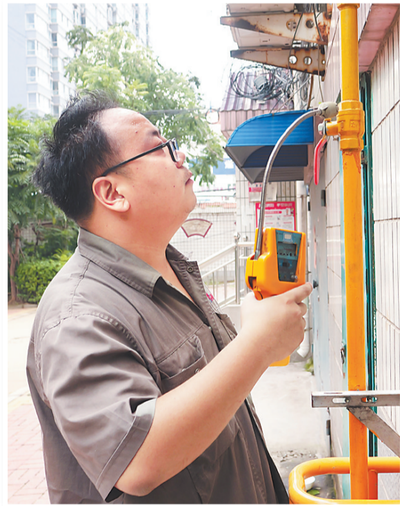
8月25日,辛集市燃气公司的维修员在安定小区检查燃气管道。 河北日报通讯员 王鹏摄
