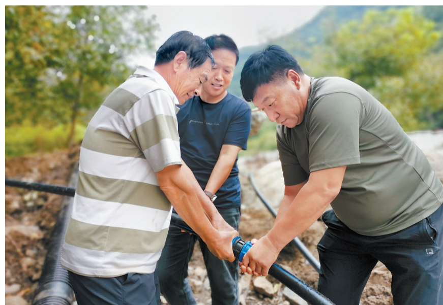
8月29日,刘贞民(中)和技术人员李国革(右)来到临城县赵庄乡梁家庄村,与村民一起抢修被冲毁的供水管道。河北日报记者 苑立立摄
