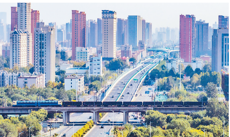
10月25日拍摄的石家庄市西二环至西三环段高架桥。石家庄市大力加强交通基础设施建设，以交通改善大民生，全力提升城市品质，加快构建高效便捷、内畅外联的交通网络体系。河北日报记者 田明摄
