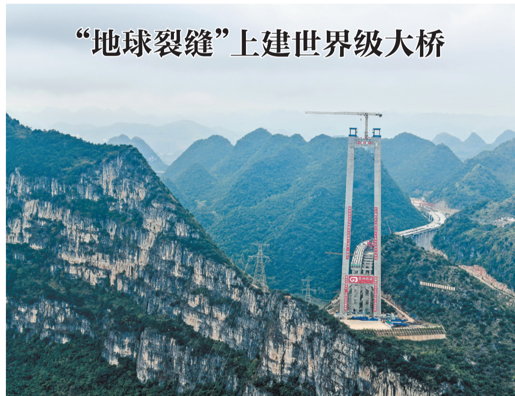
这是11月8日拍摄的贵州六安高速花江峡谷大桥建设现场。目前,六安高速花江峡谷大桥两岸主塔顺利封顶,大桥关键性施工节点获突破性进展。花江峡谷大桥是贵州六安高速公路的控制性工程,建于被称为“地球裂缝”的花江大峡谷之上,全长2890米,主跨1420米,主桥桥面与谷底的北盘江水面垂直高度达625米。新华社记者 杨文斌摄
