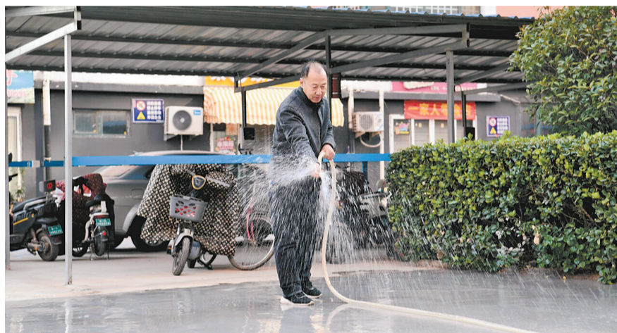
近日,邯郸市丛台区联东街道蓝天金地小区,工人对电动自行车车棚新硬化路面进行洒水养护。
