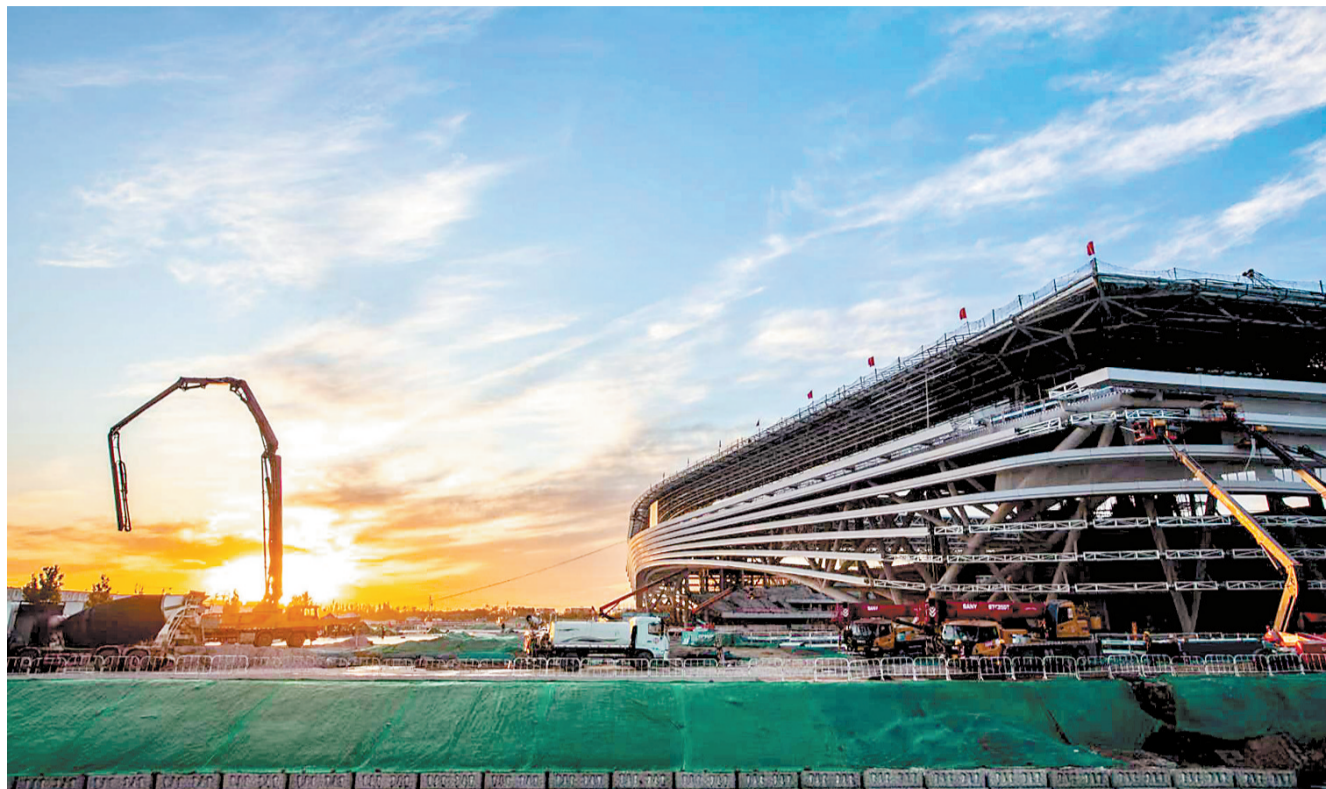
图为近日拍摄的雄安体育中心施工现场。 雄安新区供图
