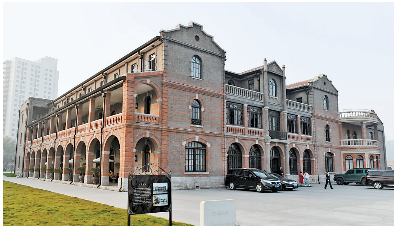
10月31日拍摄的修缮后的正太饭店。
