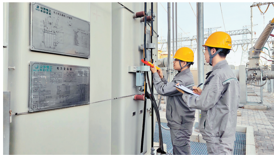
11月1日,在张北柔性直流电网工程中都换流站交流场,工作人员正在对耗能变压器进行铁芯夹件电流检测。河北日报记者 马彦铭摄
