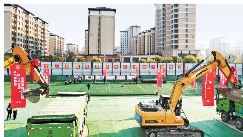
11月20日，北京大学人民医院雄安院区建设工程项目开工。图为开工现场。刘光显摄
