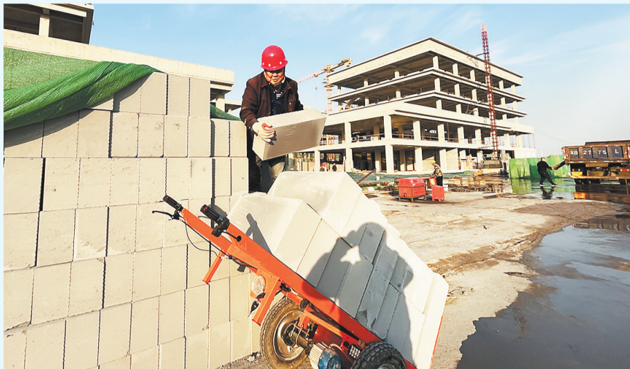
11月20日拍摄的唐山高新区京津冀科技成果转化中心项目建设现场。本组图片由河北日报记者师源摄
