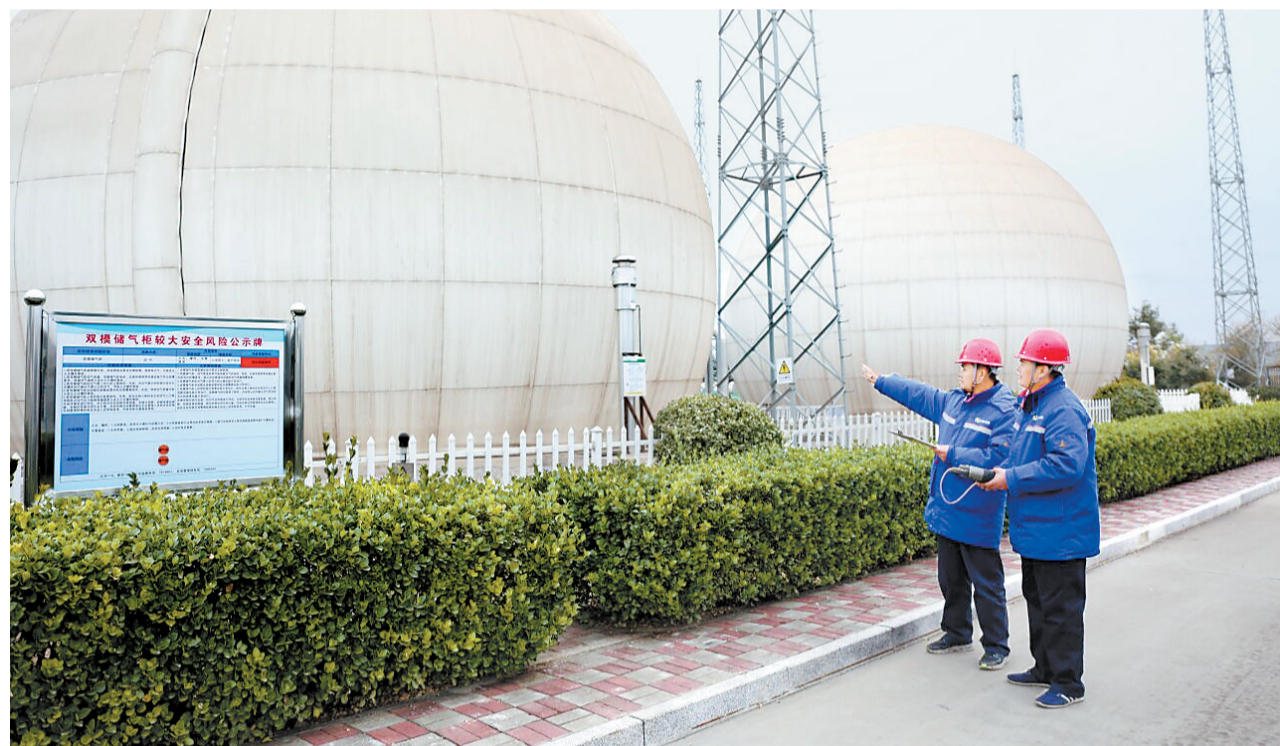
11月10日，在安平京安现代农业园区内，工人在查看生产沼气的双膜储气柜运行情况。河北日报记者 焦磊摄
