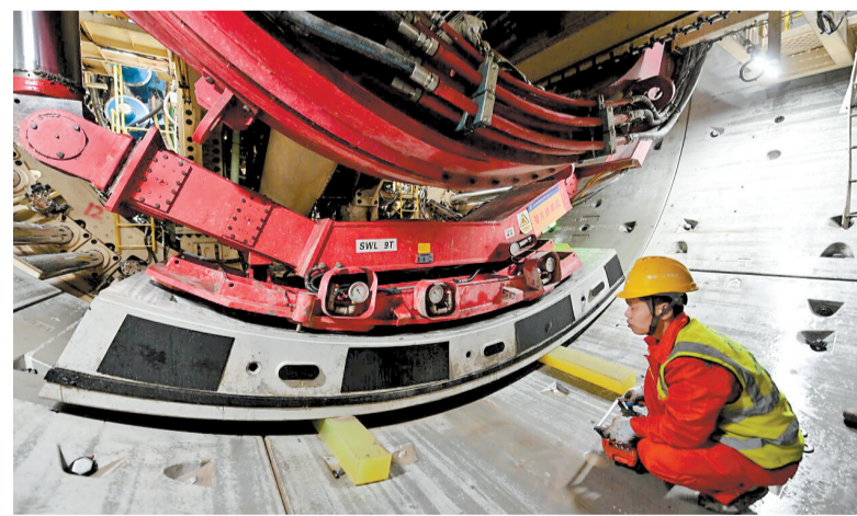
图为2月26日拍摄的隧道内施工现场。河北日报通讯员 刘 向摄
