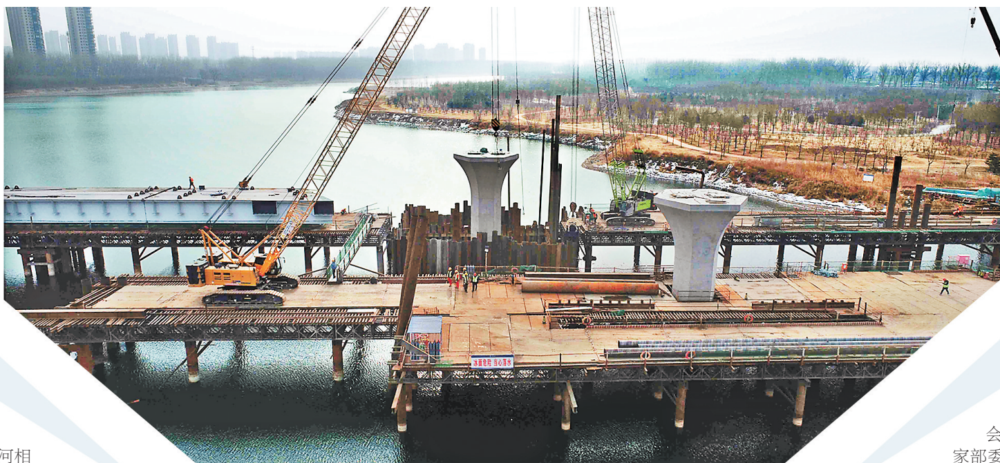
2月28日，连接通州区和廊坊大厂回族自治县的厂通路潮白河大桥建设正酣。
