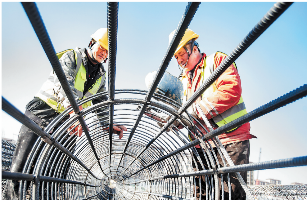
▲2月25日,来自山东滨州的建筑工人王之增(右)、姚云刚(左)正在进行钢筋笼焊接。元宵节还没有过,这两名工地上的好搭档就来到了雄安新区的建设工地上,火热的建设场面令两名初到雄安的建设者既震撼又兴奋。“早就期待着来雄安,听说很多工友都是在这里过的年。雄安,我来了!我们和来自全国各地的雄安建设者一起冲刺雄安建设的新年开门红。”王之增说。
