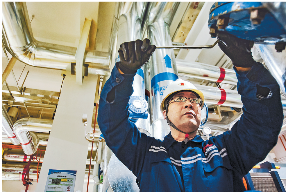
▲3月21日，容东4号能源站设备维护检修现场，安全员中建伟正在拆除供暖管线的过滤器挡板，对过滤器进行清污作业。“供暖不停工，为了新一年的供暖工作顺利，及时做好设备维护和安全检修是我们的责任。”中建伟认真地说。供暖季刚一结束，中建伟便与工友们展开设备维护和检修工作，第一时间做好问题排查，为下一个供暖季安全稳定运行做好充足准备。
