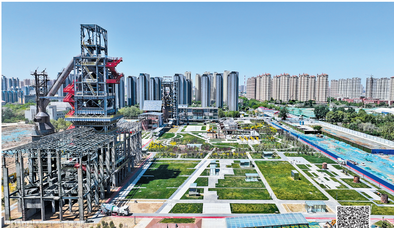
4月23日航拍的石钢工业遗址公园项目现场。石钢工业遗址公园是石家庄市“6+2+2”城市更新重点项目之一,4月25日正式对外开放。 河北日报记者 史晟全摄
